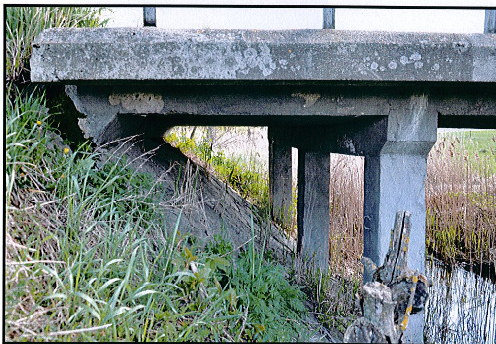
Fot. 8. Widok na wspornik i płytę pomostu oraz stożek
