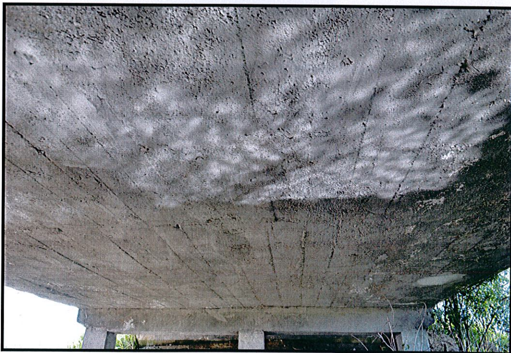
Fot. 6. Konstrukcja obiektu od spodu
