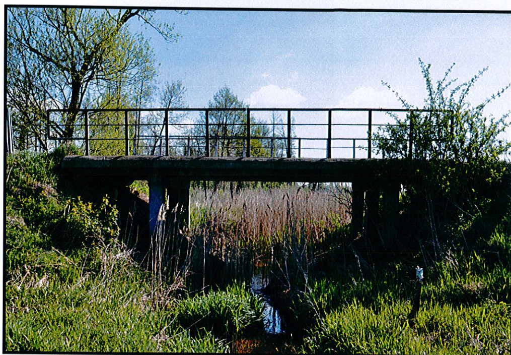
Fot. 3. Widok z boku na most od strony - GW.
