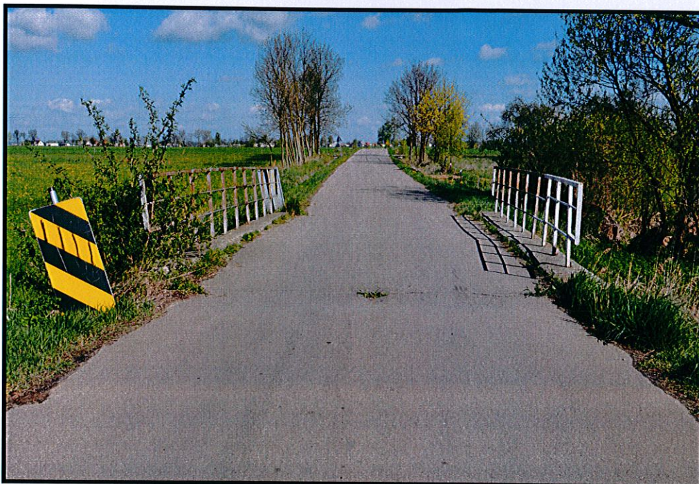
Fot. 1. Widok wjazdu na most od strony południowej.
