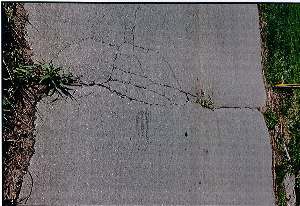
Fot. 9. Nawierzchnia, pobocza i balustrady
