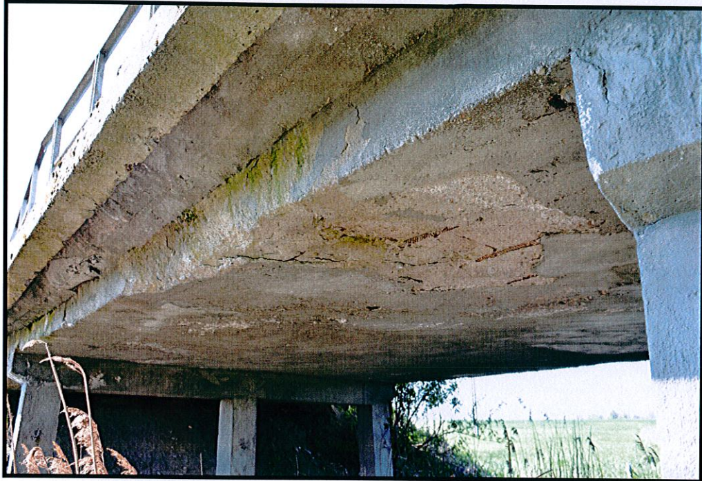
Fot. 5. Gzyms od spodu i podpora obiektu
